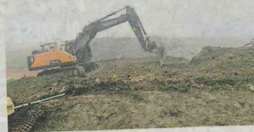
un carico massimo di 50 tonnellate, e sarà dotato di tutti i sistemi a garanzia della sicurezza stradale.
