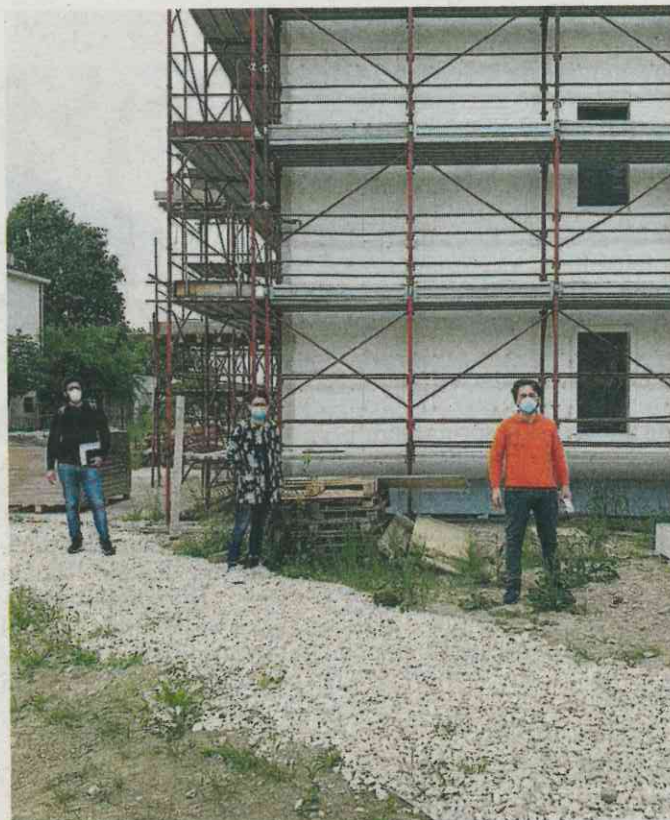
A destra, il sindaco Simone Saletti sul cantiere di via Torricelli
