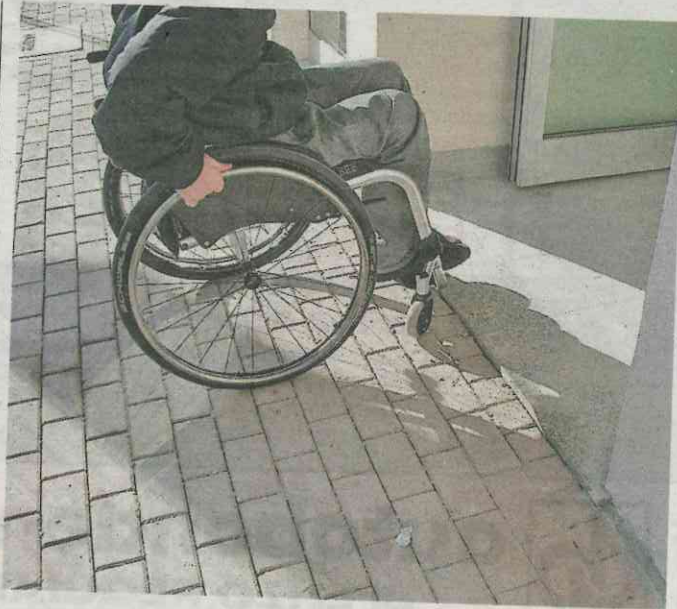
Lo sfogo di un signore in sedia a rotelle che vive al terzo piano, senza ascensore, di una palazzina Acer e che chiede di poter cambiare
