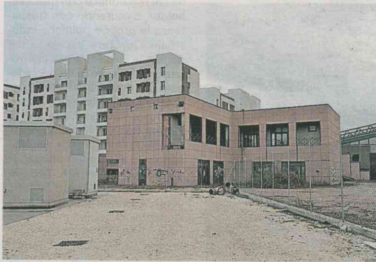
Uno degli immobili fatiscenti nell'area dell'ex Palazzo degli Specchi
