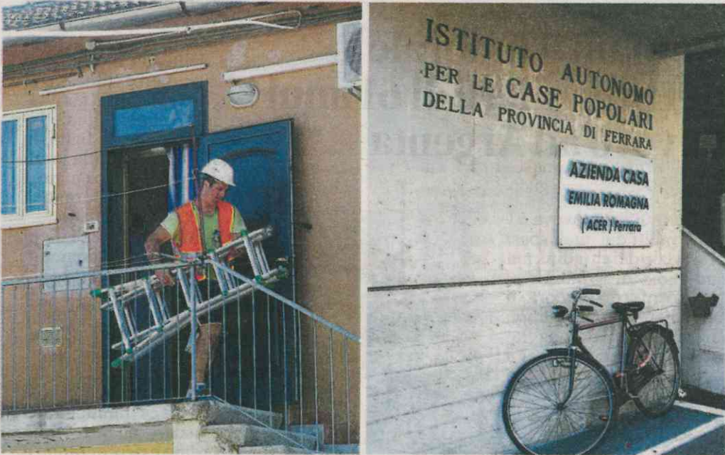
Nella foto in alto lo sgombero dalle case popolari di via Marconi per il cedimento del tetto. In basso a sinistra, un tecnico Acer al lavoro in uno degli appartamenti delle case popolari. In basso a destra la sede di Acer, Azienda casa Emilia Romagna, a Ferrara. /FOTO FILIPPO RUBIN
