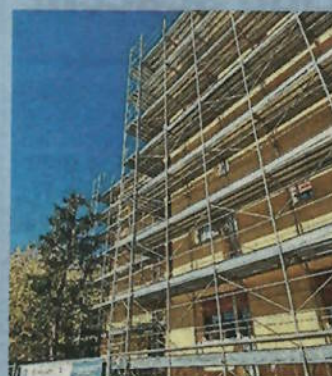
Un'immagine dei lavori in corso
