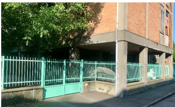
FE- Via Franchi Bononi 27 – Tinteggiatura cancellata condominiale
