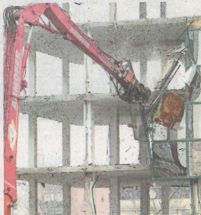
Una tenaglia gigantesca al lavoro su una facciata dell'ex Palaspecchi
