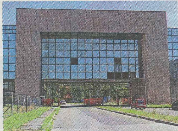
Il "ponte" (così lo chiamano i tecnici) principale porta d'accesso all'area
