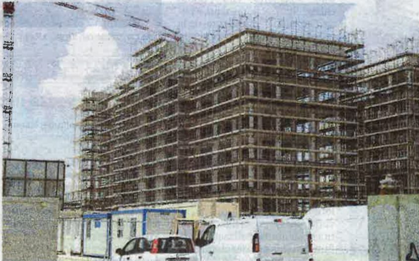
Il cantiere dello studentato e delle case di edilizia sociale in via Beethoven
