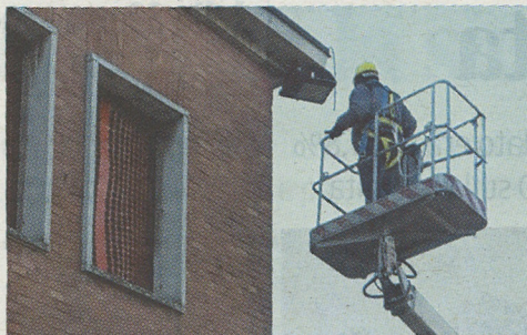
Controlli agli edifici dell'ex stazione anche con la piattaforma aerea
